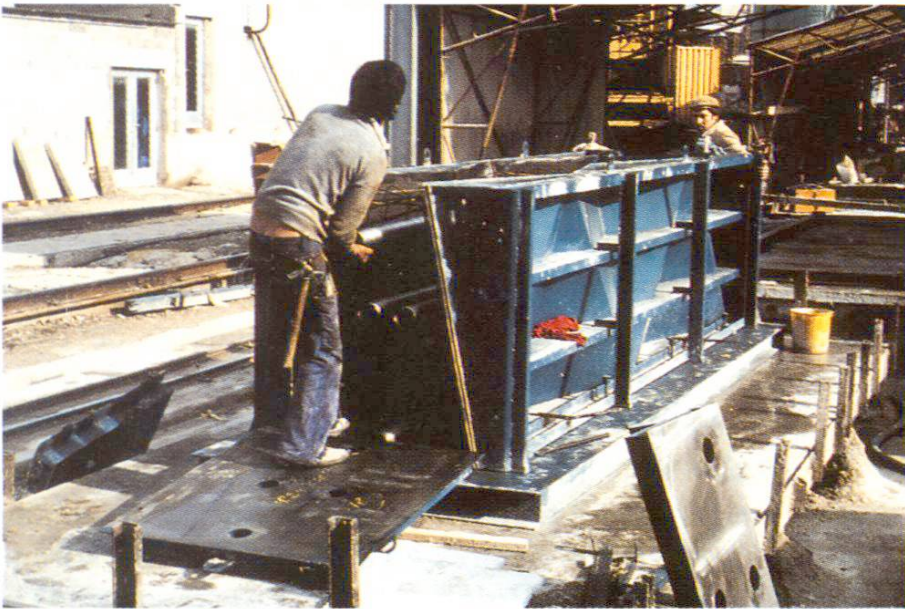
Coffrage métallique pour colonne type B. Préfabrication: Prelco, Genève. 5
