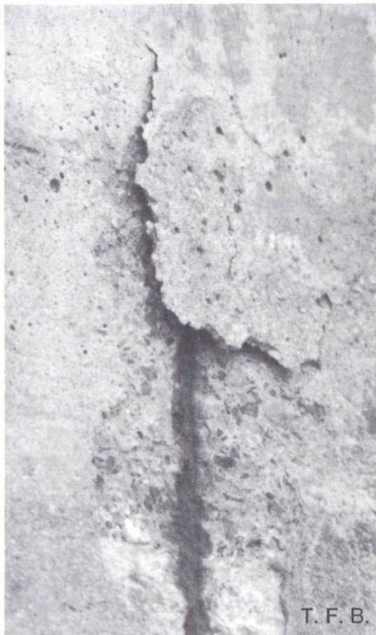
Fig. 5 Gonflement et écaillage provoqués par la corrosion de l'armature.
