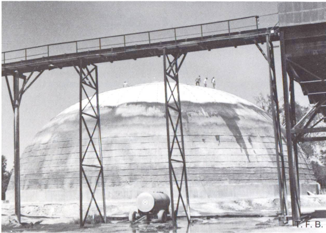
Fig. 7 Coupole ( \varnothing = 37,8 m, h = 15,3 m) pendant l'application de la première couche de béton projeté. On peut marcher sur le coffrage aérosupporté.
