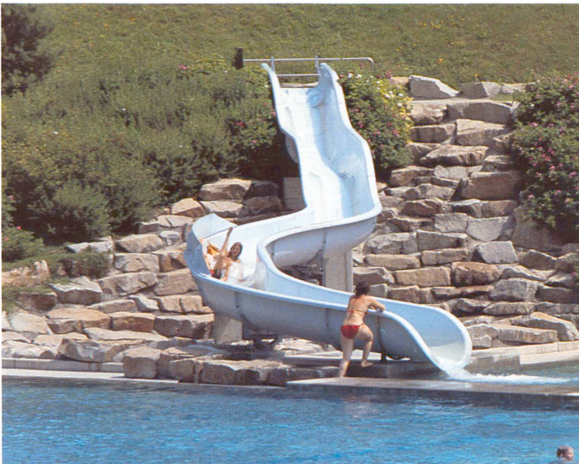
Toboggan-rigole incorporé à une petite colline formée de pierres naturelles servant aussi d'escalier (Möhlin AG)
