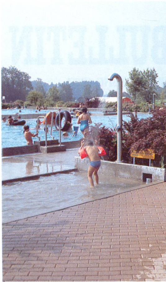
Accès à la zone des bassins par le pediluve (bassin bain de pieds) combiné avec douche (Muri AG)
