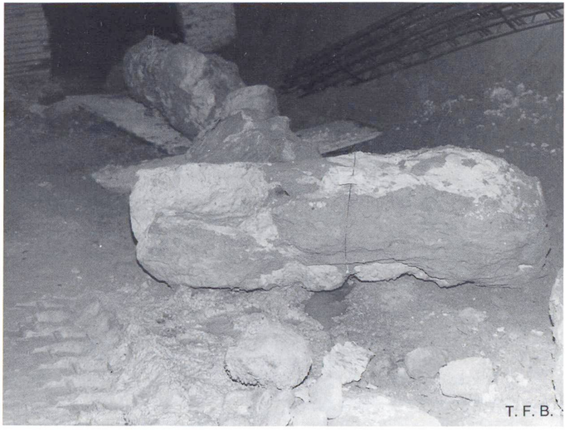
Fig.9 Partie d'une poutre injectée. Pour tester les propriétés des matériaux, on a exécuté une poutre d'essai puis on l'a déterrée.
