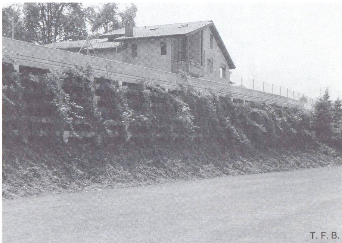
Fig. 3 Dès la phase du projet, il faut prévoir qui sera responsable de l'entretien et quel en sera le coût (Terrain de sport de Buochs). Mur de soutènement en éléments avec plantations.
