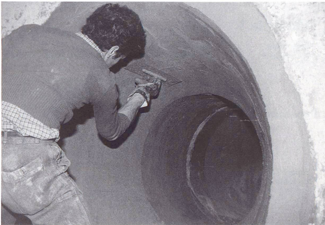
Fig. 7 Application d'un revêtement en mortier de ciment.
