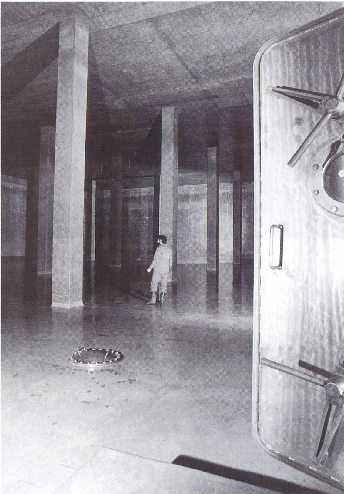
Fig. 10 Vue à l'intérieur d'un réservoir d'eau potable. Les matériaux sont le béton et l'acier inox.
