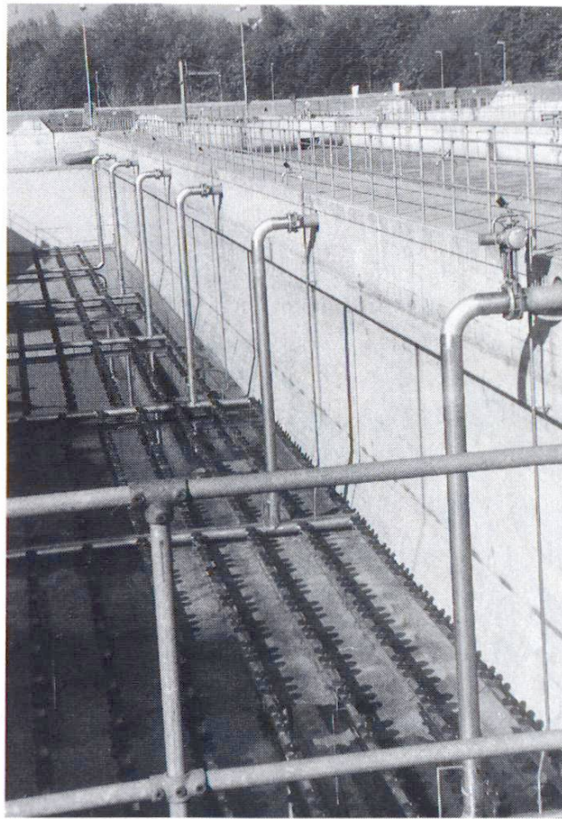
Fig. 11 Vue d'un bassin d'aération. Les matériaux sont le béton et l'acier inox.
