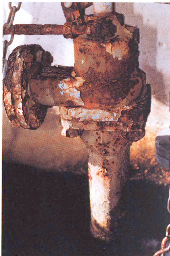
Fig. 13 Service des eaux d'un village: «Prévenir est aussi plus économique que guérir».
