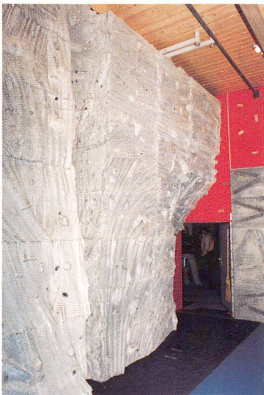
Paroi d'escalade construite après coup (Halle des sports de Grindelwald, sous la tribune). 7
