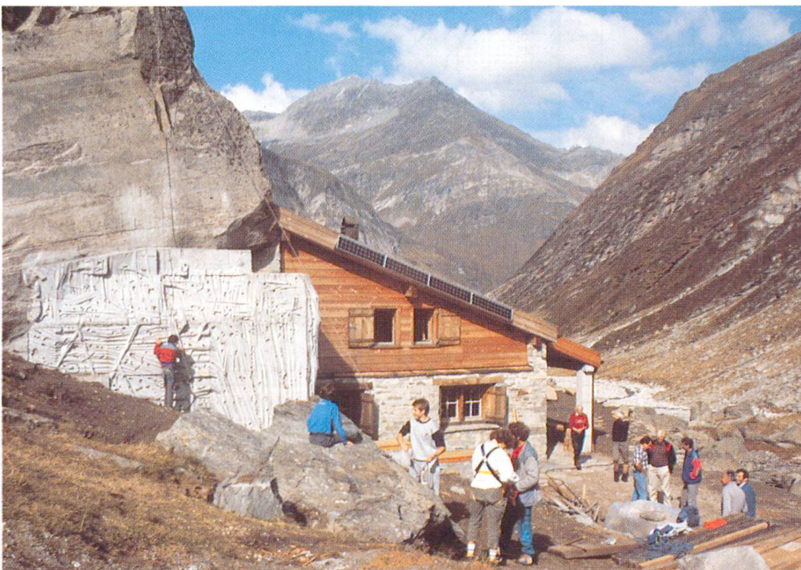
Mur de soutènement pour déviation d'avalanches conçu comme paroi d'escalade (Cabane de Lenta GR). 9
