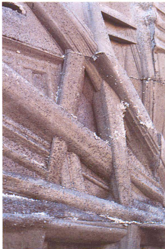
Détail après décoffrage, avant nettoyage.
