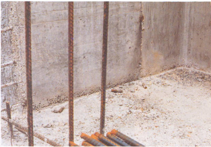
Fig. 7 Raccord mural intérieur.
