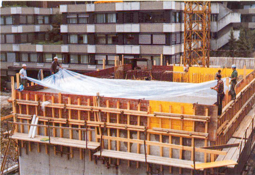
Fig. 13 Recouvrement avec une bâche en plastique.
