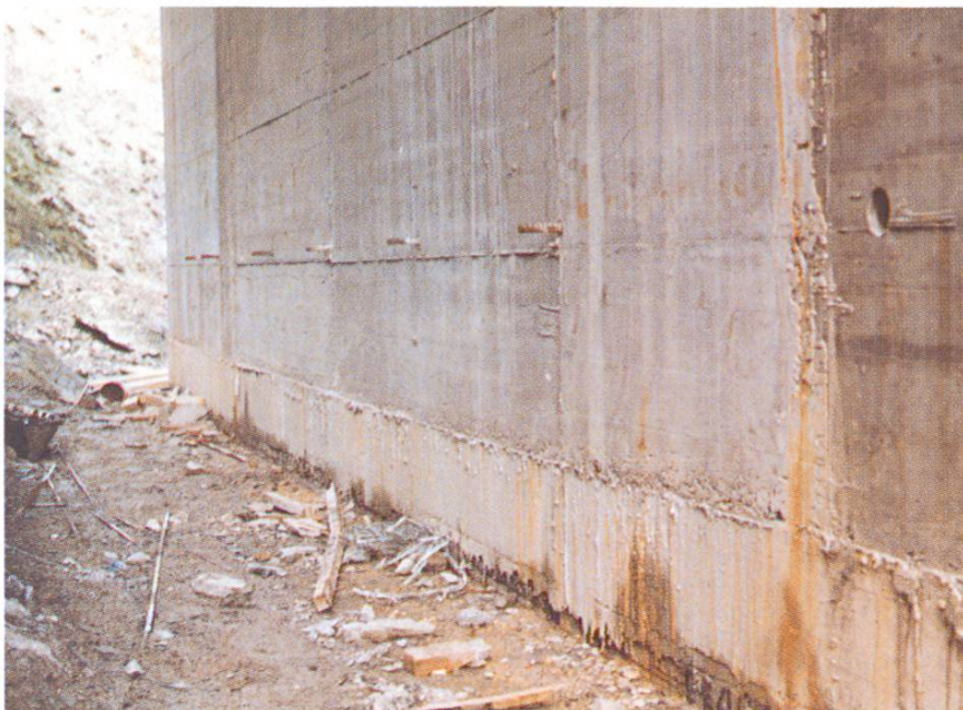
Fig. 8 Raccord mural extérieur.
