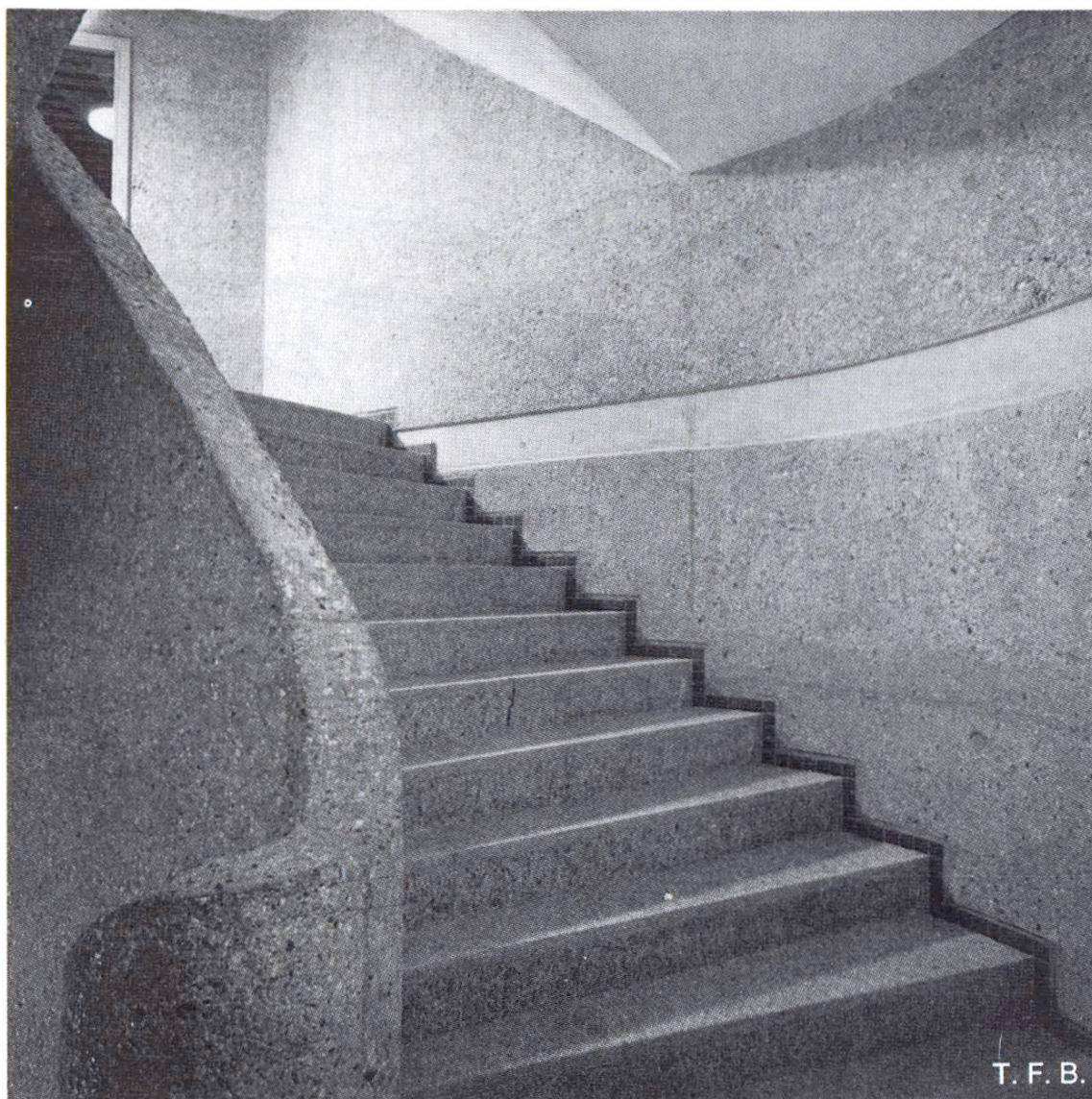
Fig. 7 Béton apparent dans la cage d'escalier
