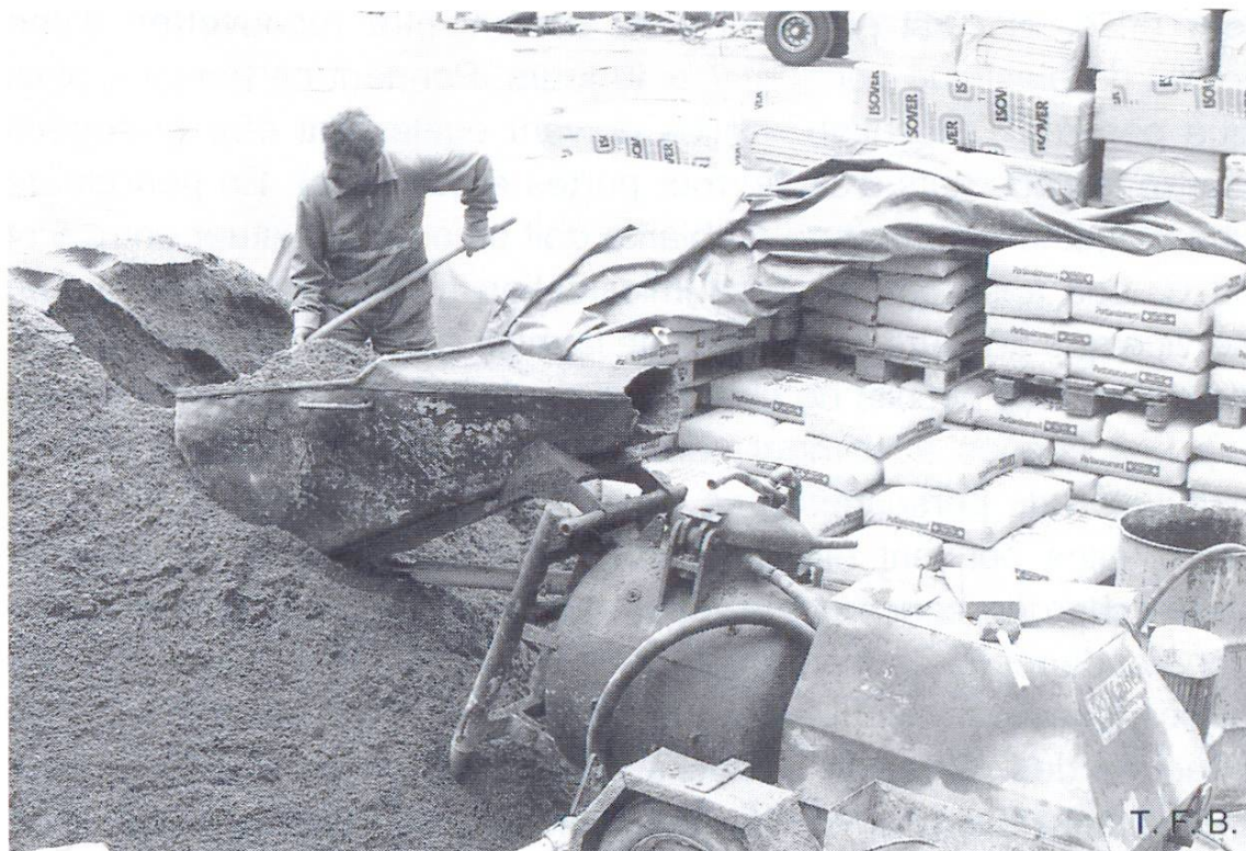
Fig. 2 Mélange du mortier et pompage au lieu de la mise en place.
