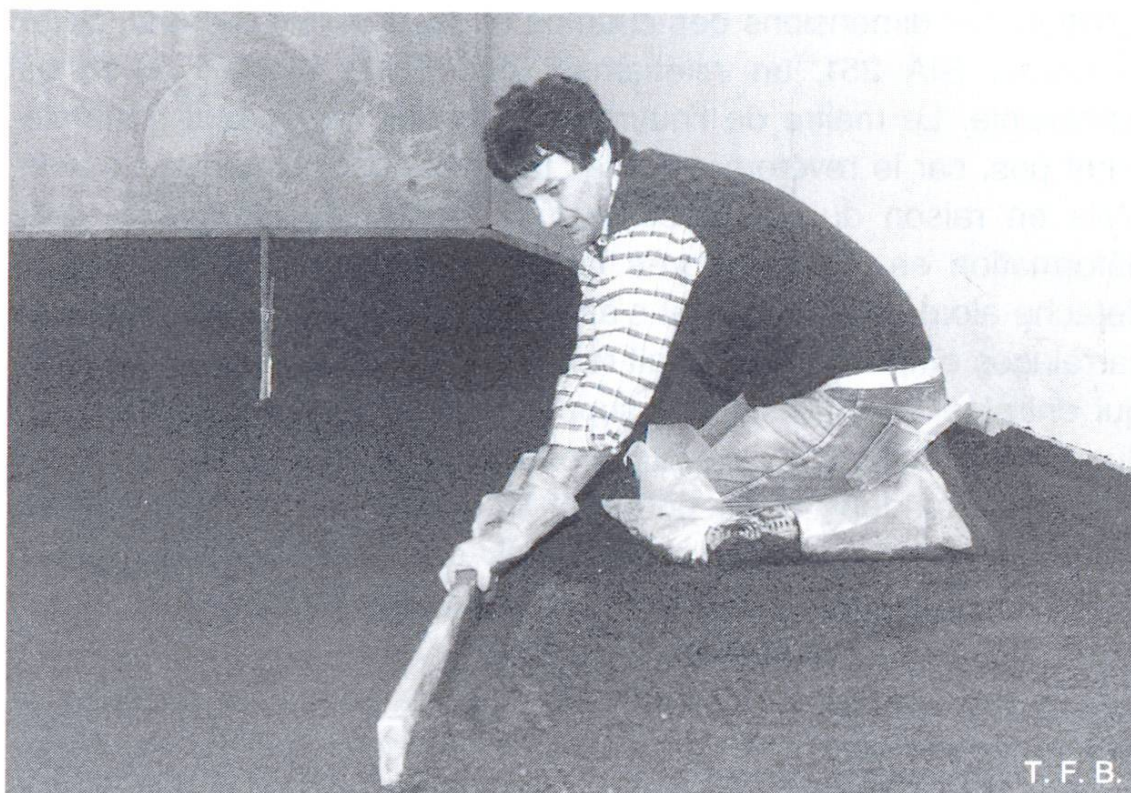
Fig. 3 Dressage du mortier au niveau prescrit.
