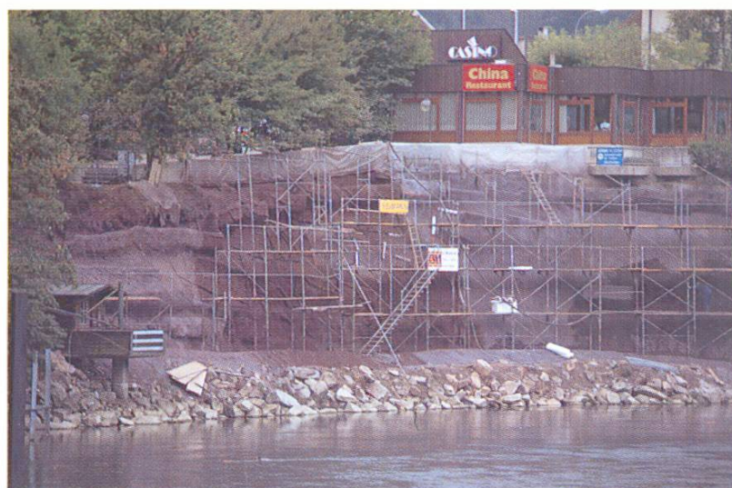
Fig. 10 Echafaudage pour la projection du béton
