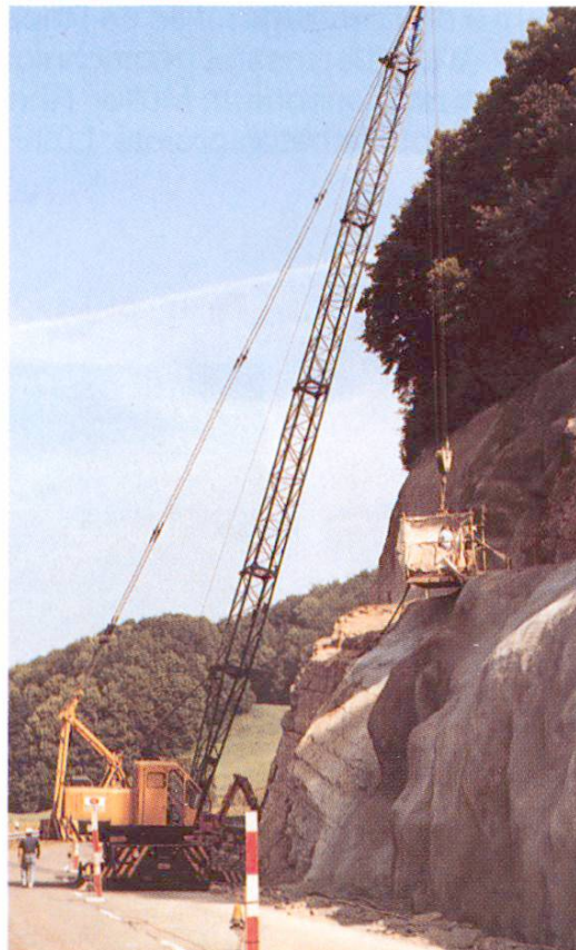
Fig. 14 Projection du béton depuis une nacelle volante
