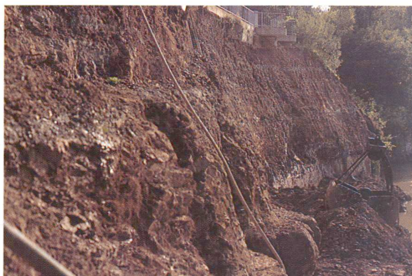
Fig. 9 Déblai (inclinaison variant!)
