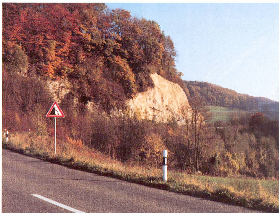
Fig. 18 Les travaux de stabilisation sur la paroi rocheuse au moyen de béton projeté et de treillis ont été limités à l'indispensable, mais le danger de chutes de pierres a tout de même pu être éliminé dans une large mesure
