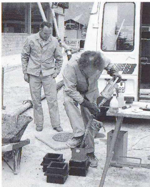
Compactage du béton au moyen d'un vibreur.
