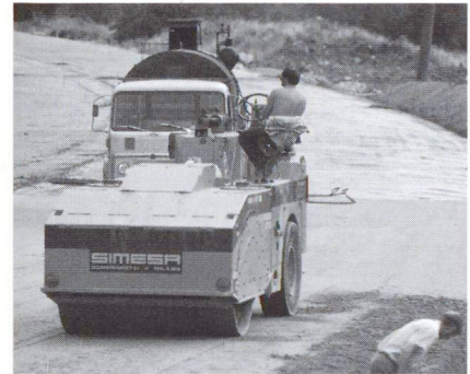
Compactage avec un rouleau vibrant.
