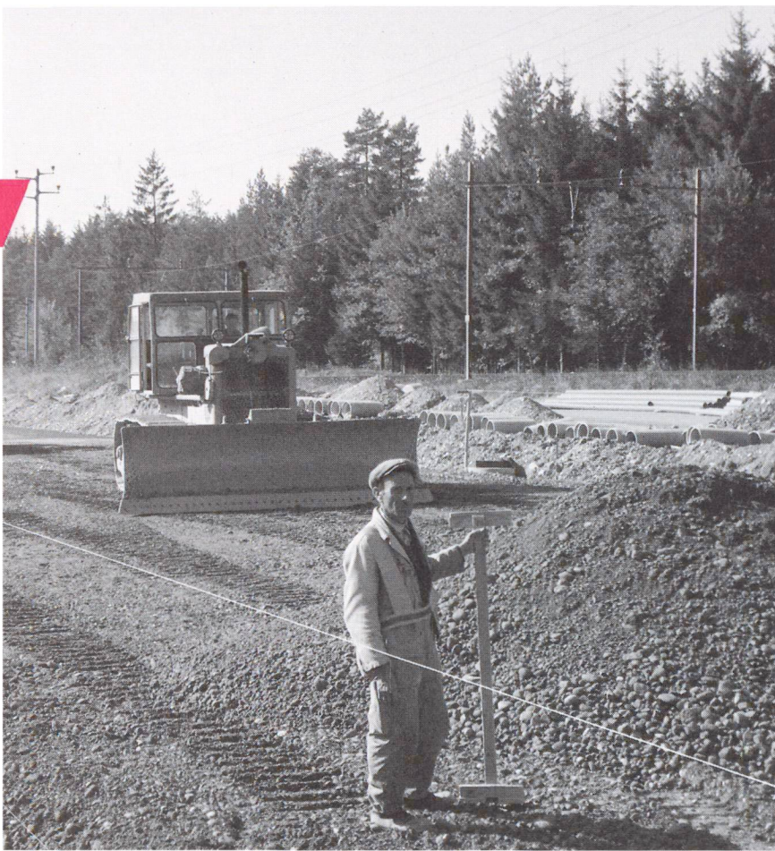
Nivellement au bulldozer.
