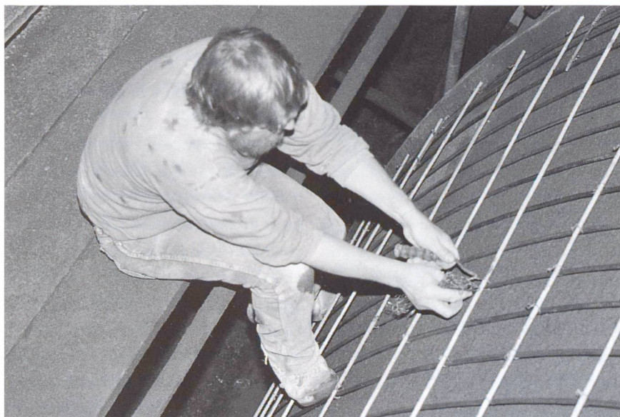
Pose de la seconde armature.
