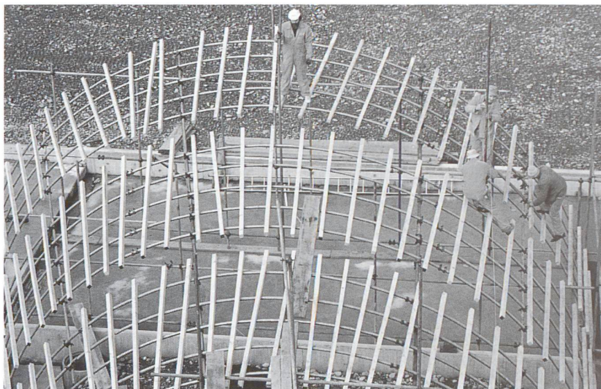
Le cintre de bétonnage en cours de montage.
