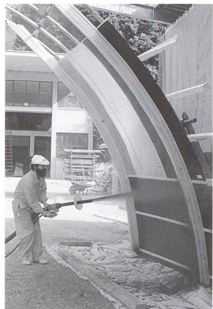
Les essais préalables effectués au chantier de l'entreprise ont fourni d'importants renseignements pour l'exécution des travaux en béton projeté.
