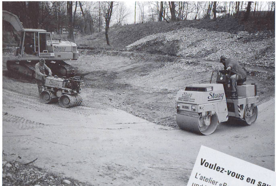
Compactage de matériaux stabilisés à la chaux lors de la réalisation d'un étang.
