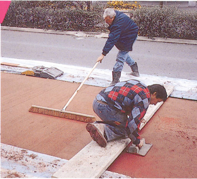
Une utilisation intéressante des ajouts du béton: revêtements en béton teinté aux arrêts de bus.
