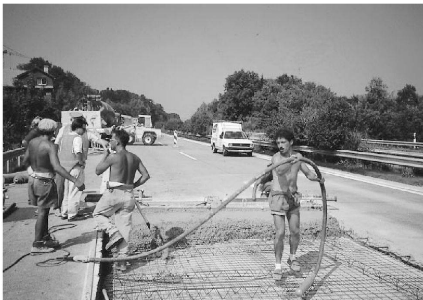
Remplacement partiel d'une dalle en béton (A1).
