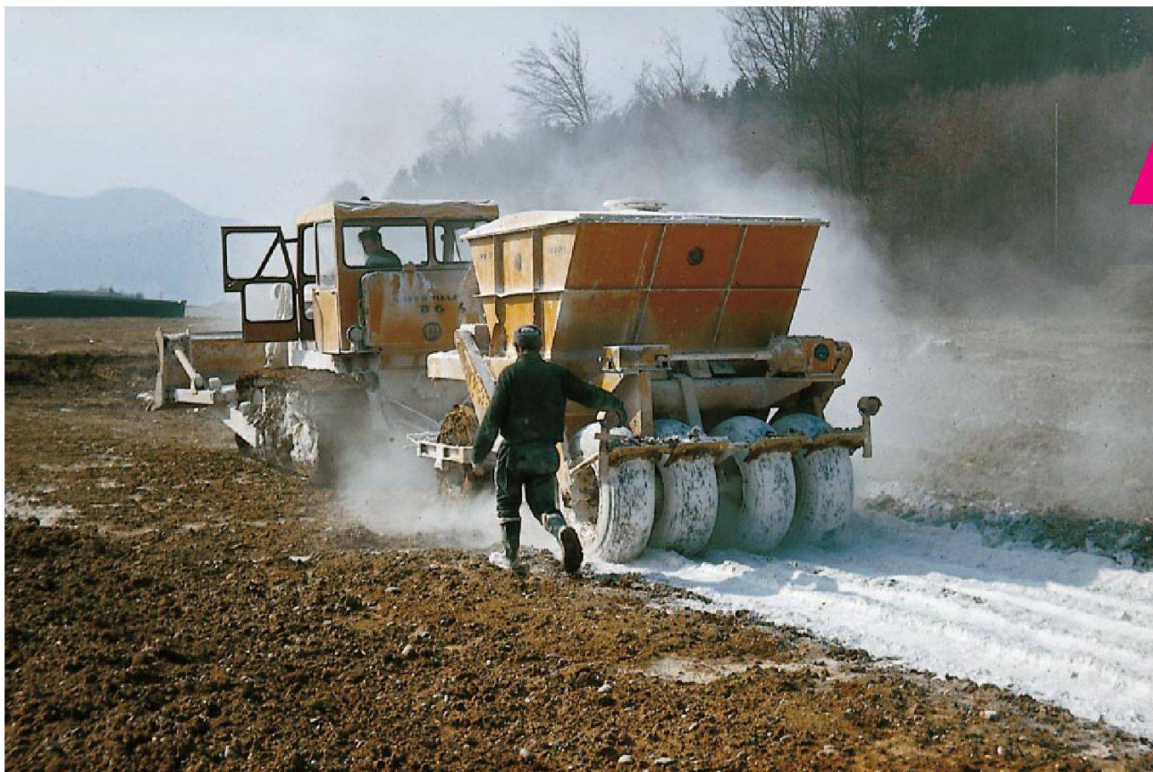
Epandage de chaux vive sur la plate-forme.
