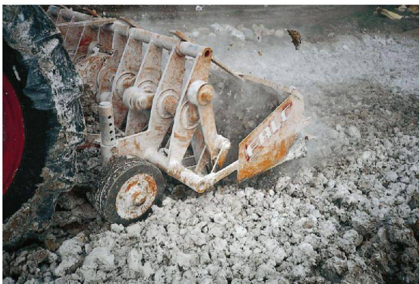
Malaxage de la chaux vive avec un pulvi-mixer.
