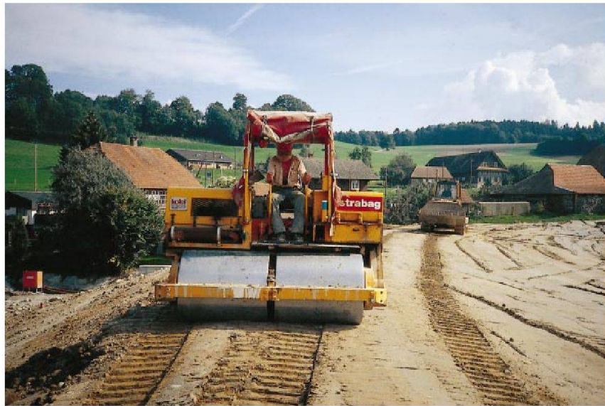
Compaction d'un sol stabilisé au moyen d'un rouleau vibrant.
