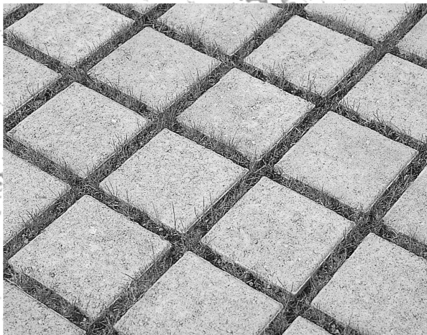
Pavage perméable à l'eau avec joints engazonnés.
