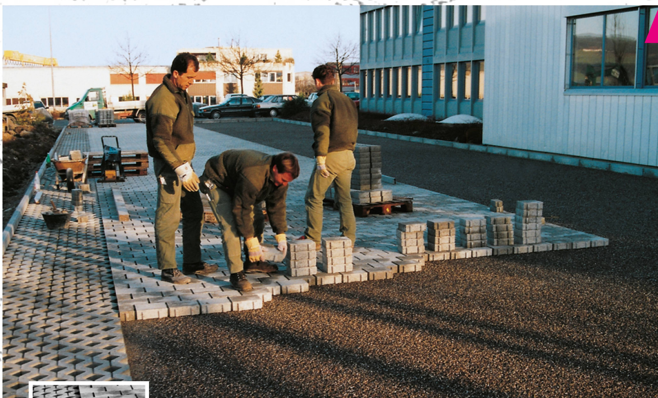
Pose manuelle de pavés en béton.
