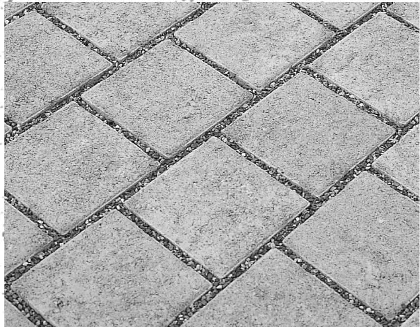
Pavage perméable à l'eau avec joints gravillonnés.
