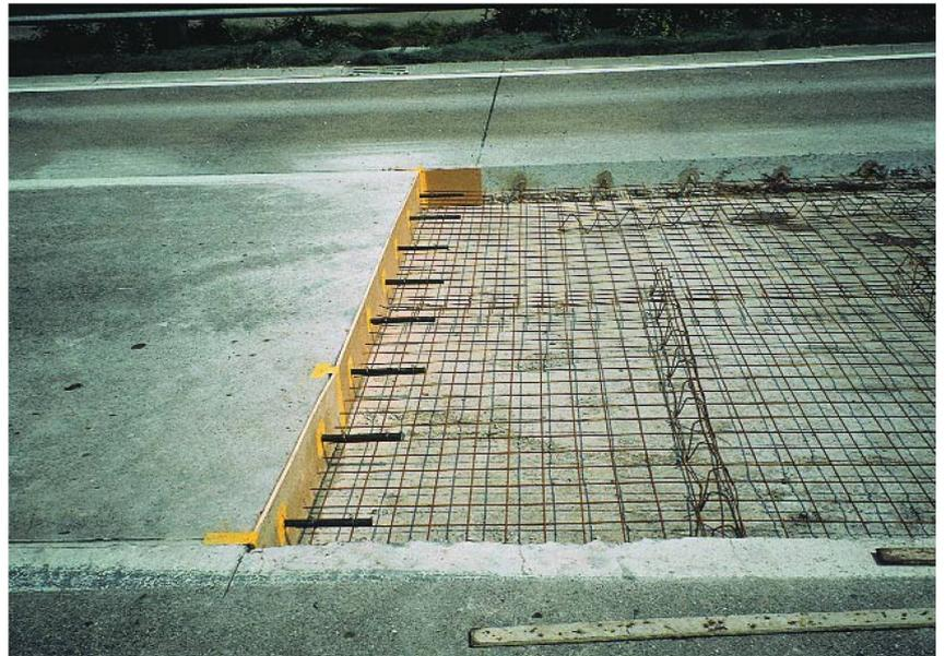
**Remplacement de dalles: préparé pour le bétonnage.**
