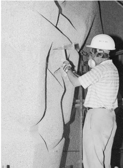
Fig. 11 Finissage de la surface en béton projeté par un sculpteur.
