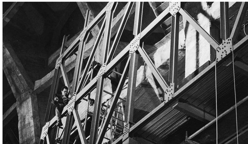
Fig. 4 Montage de la structure porteuse.
