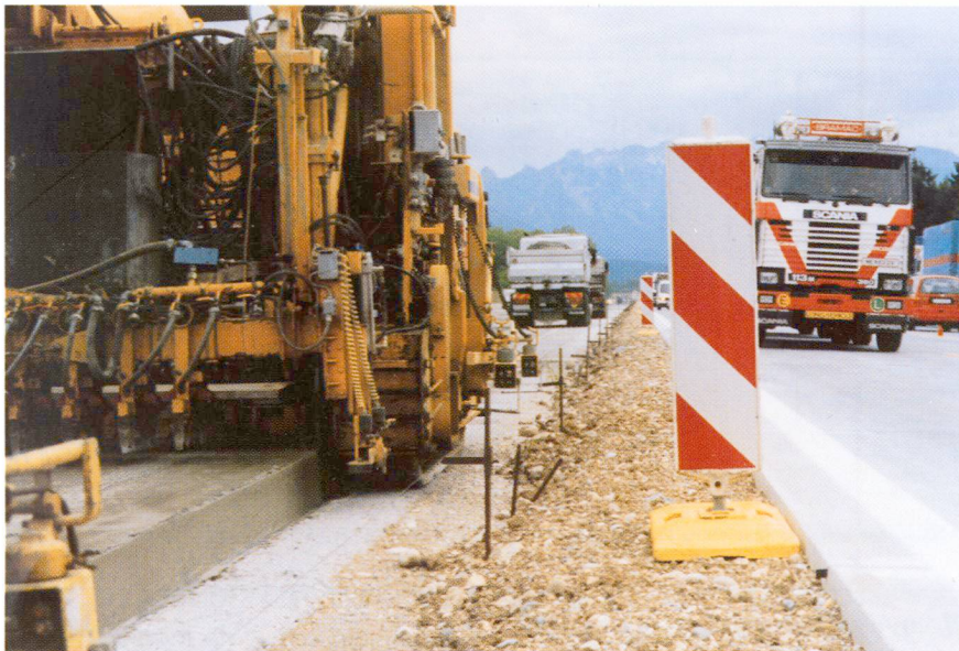
Fig. 3 Les chaussées en béton modernes sont mises en place avec des finisseuses à coffrage glissant.
