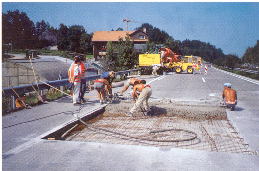
Fig. 5 Remplacement de dalles et utilisation de béton à haute résistance initiale en Suisse.
