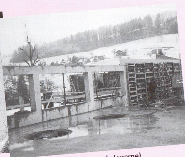
Béton apparent SCC (région de Lucerne)
