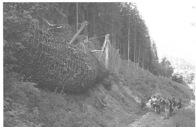
Abb. Tirol 1: Stahlseilsicherung im Paznauntal
