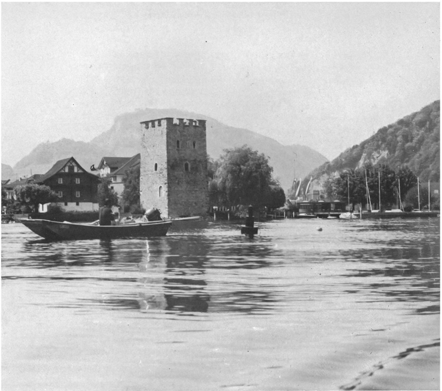
Abb. 4 Schnitzturm. Der 1428 erstmals urkundlich erwähnte Turm ist aus burgenkundlichen und historischen Überlegungen in die Zeit kurz nach dem Morgartenkrieg zu datieren.
