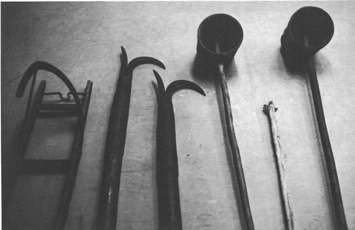
7. Weitere Brandbekämpfungshilfen aus der Frühzeit der Feuerbekämpfung: Mit den «Feuerhaken» wurde versucht, dem Feuer leicht brennbares Material zu entziehen, die Feuerleitern dienten zur Rettung von Mensch und Habe und die mit einem Stil versehenen Eimer zum Schöpfen von Wasser aus einem tiefliegenden Reservoir. — Feuerwehrlokal Stans.
