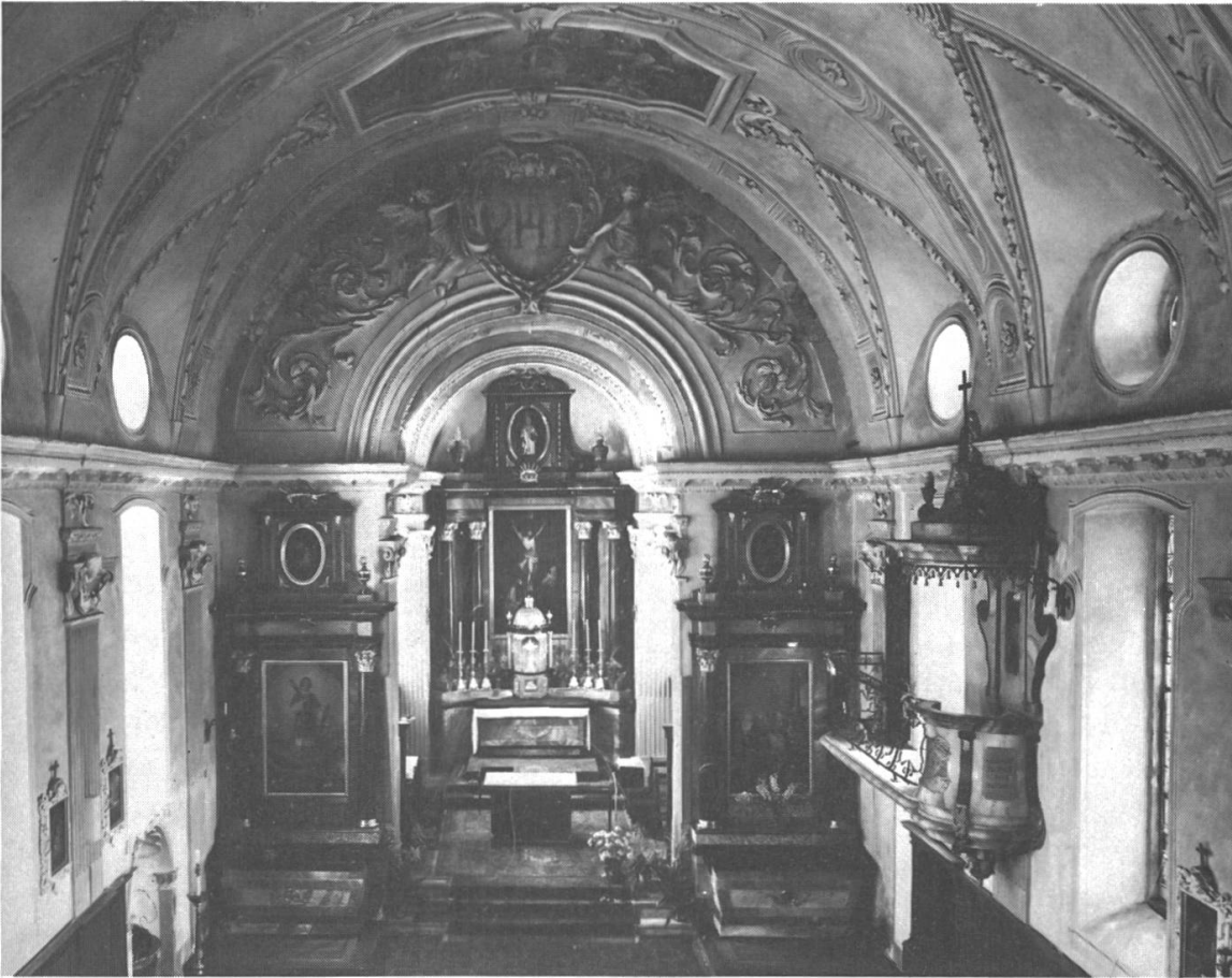
24. Ansicht Richtung Chor vor der Restaurierung
