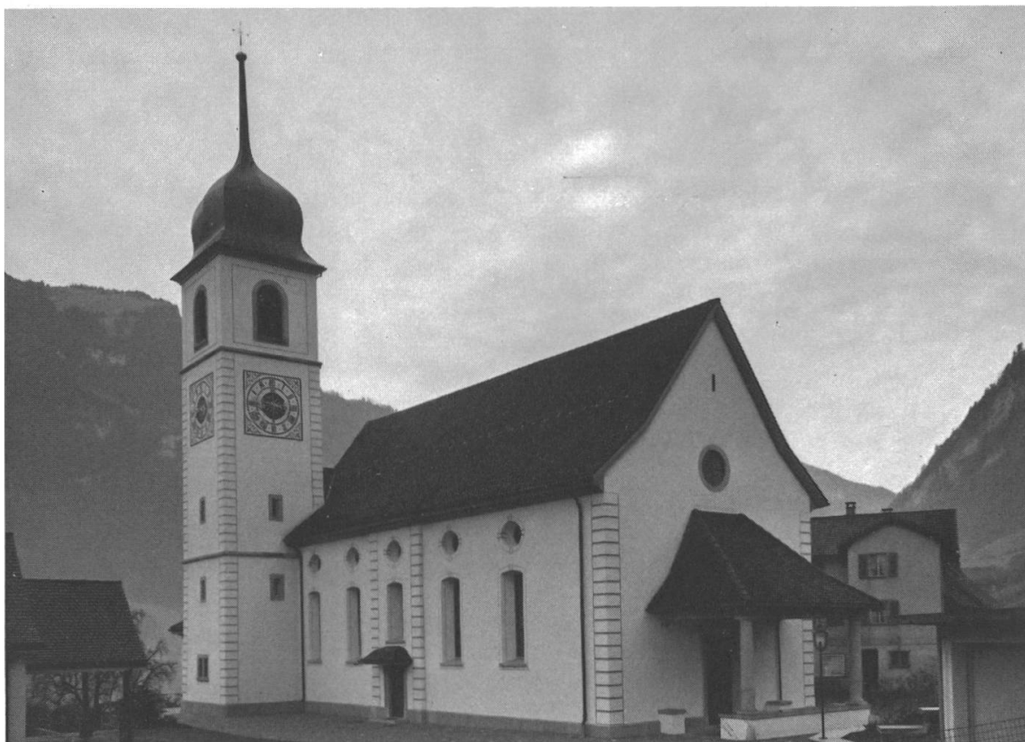
21. Gleiche Ansicht nach der Restaurierung
