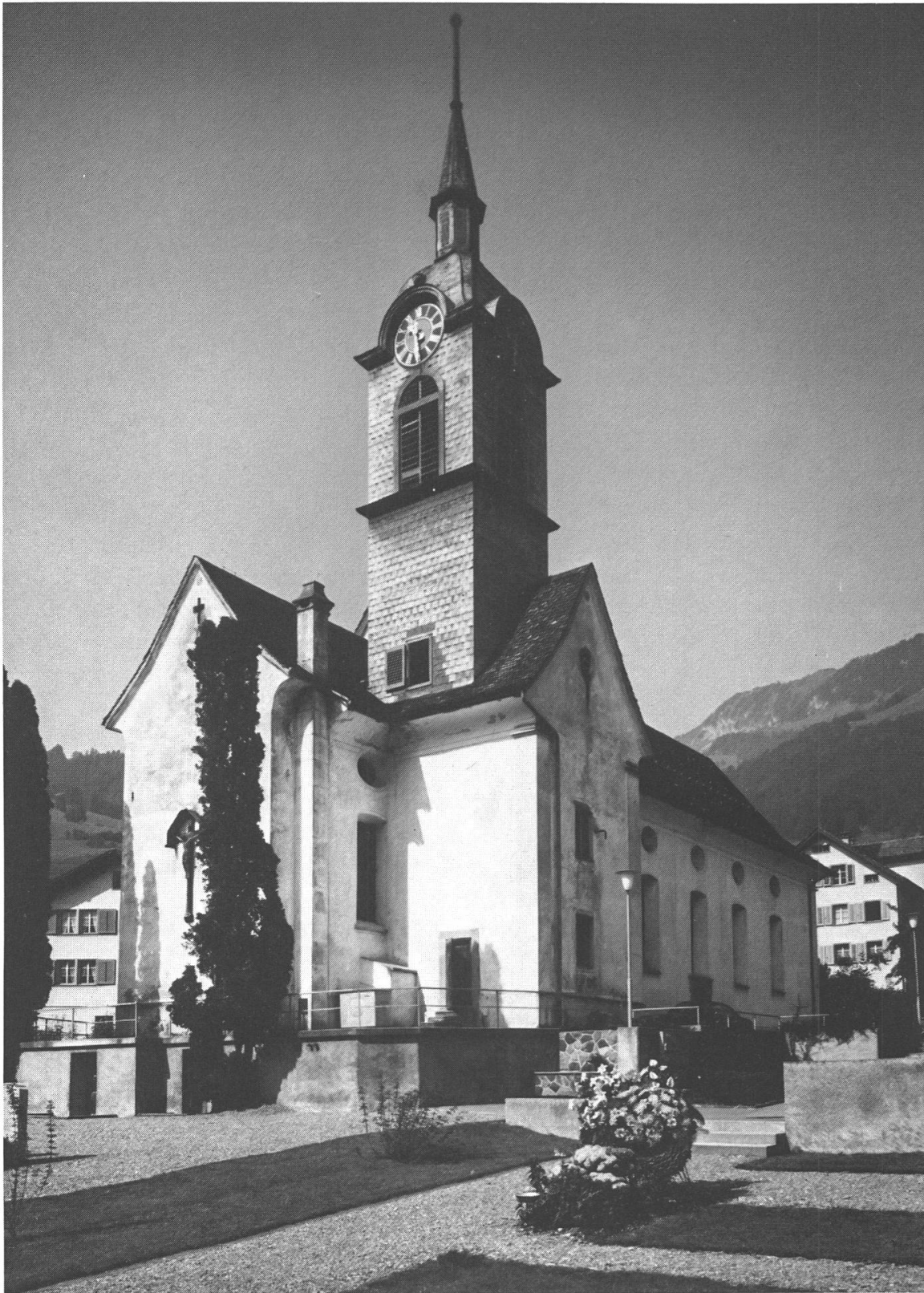
22. Ansicht von Osten vor der Restaurierung
