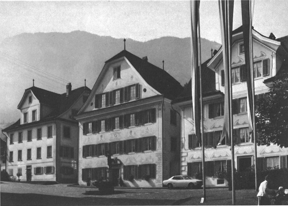
17. In den letzten Jahren führten etliche Besitzer von Baudenkmalern aus der unmittelbaren Nach-Brandzeit an ihren Häusern fachgerechte Restaurationen durch. Das Bild zeigt die herrschaftlichen Häuser am Rathausplatz.
