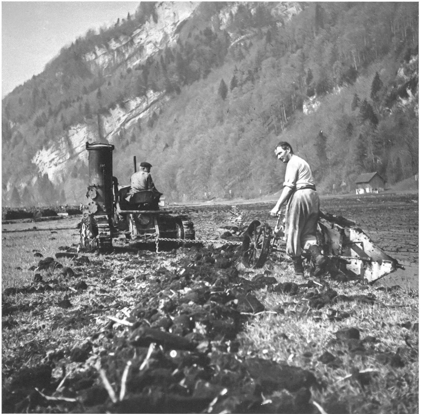
18 Bis 1941 wurde das Drachenried in Ennetmoos als Streueland genutzt. Unter der Initiative von Nationalrat Wagner nahm eine Meliorationsgenossenschaft die Trockenlegung an die Hand. Im Winter 1941/42 wurde der erste Teil und im Winter 1942/43 der Rest des Riedes entwässert. Fast die gesamte Planie des Aushubmaterials und die Auffüllung der vielen Riedgräben erfolgte durch ein Detachement internierter Polen. Auch beim Neuumbruch haben die Polen mitgeholfen. Das Bild zeigt den ersten Umbruch des Drachenriedes im Mai 1942. Der Moorigel-Pflug wird von einem 55 Ps Bulldogg-Raupentruktor mit Holzvergaser gezogen. Gutes Pflügen beim ersten Umbruch war für die rationelle Durchführung der folgenden Ackerarbeiten von grösster Wichtigkeit.
