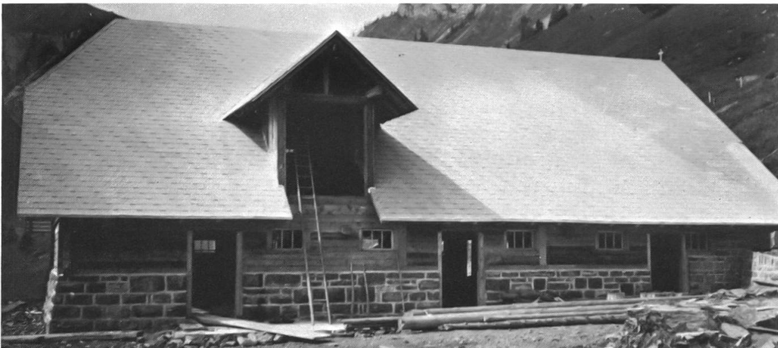
50 Der Eggengaden auf Lutersee wurde 1945 von einer Lawine eingedrückt. Er wurde wieder instandgestellt und mit Stahlseilen verankert. Im Winter 1949/50 wurde er erneut von einer Lawine eingedrückt. Bild vom 1. Mai 1950.
