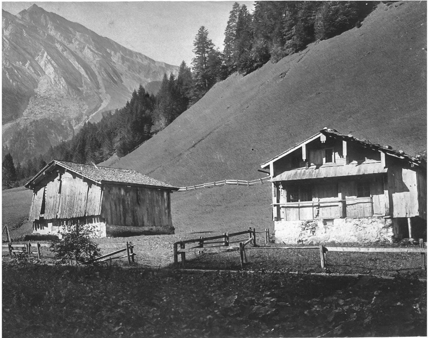
63 Gorneren, ehemals hinterstes Heimen im Choltal, wurde 1958 von der Genossenkorporation Emmetten gekauft und wird heute als Rinderalp genutzt. Das Bild zeigt Haus und Stall in Hinter-Gorneren um 1900, beide Bauten stammen aus dem Ende des 18. Jahrhunderts. Der Stall steht derzeit noch unverändert, das Haus ist bis zur Unkenntlichkeit umgebaut.
