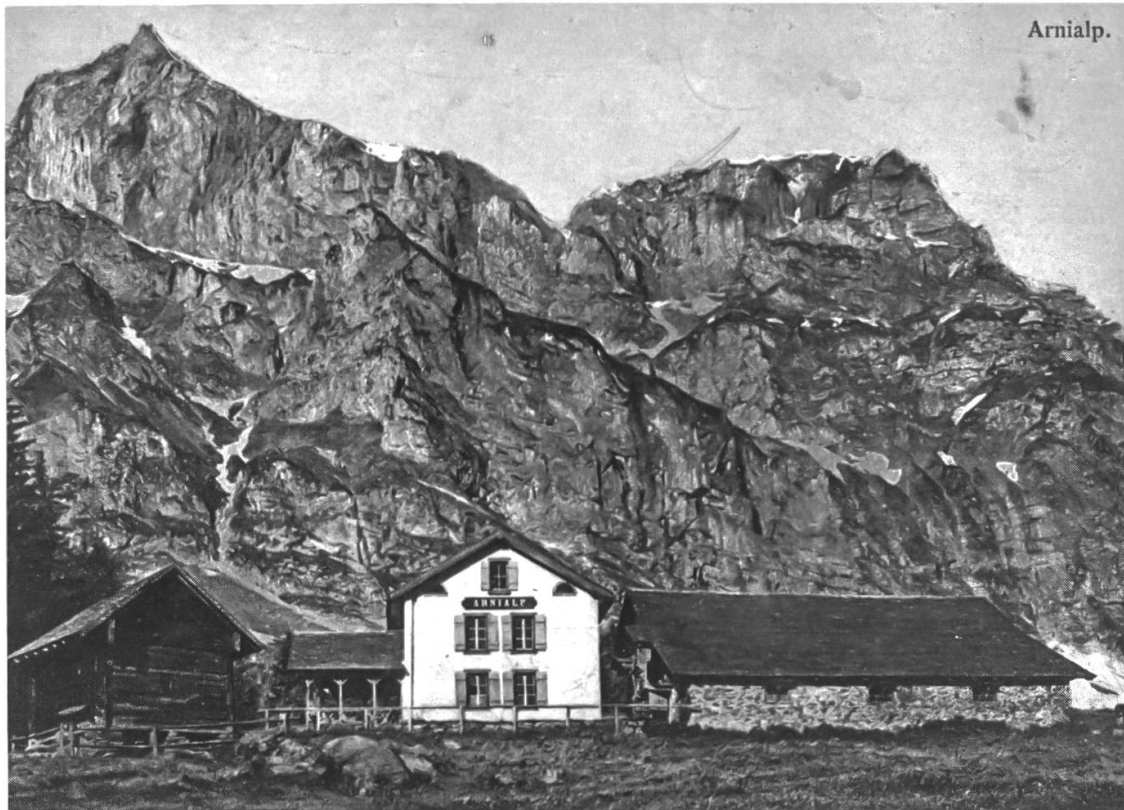
48 Die alten Gebäude von Arni-Wang lagen zirka 300 m nordöstlich und 40 m tiefer als die heutige Alpsiedlung Arni-Wang. Im Haus wurde eine Sommerwirtschaft betrieben. Links an der Wirtschaft war eine offene Tanzlaube angebaut, weiter links stand der Speicher und rechts von der Wirtschaft der Alpstall. Am 30. November 1935 ist das Arnialp-Hotel abgebrannt. Die neue Arni-Hütte wurde 1936 am jetzigen Standort gebaut. Das Bild zeigt den Zustand der alten Arni-Wang-Siedlung um 1900.
