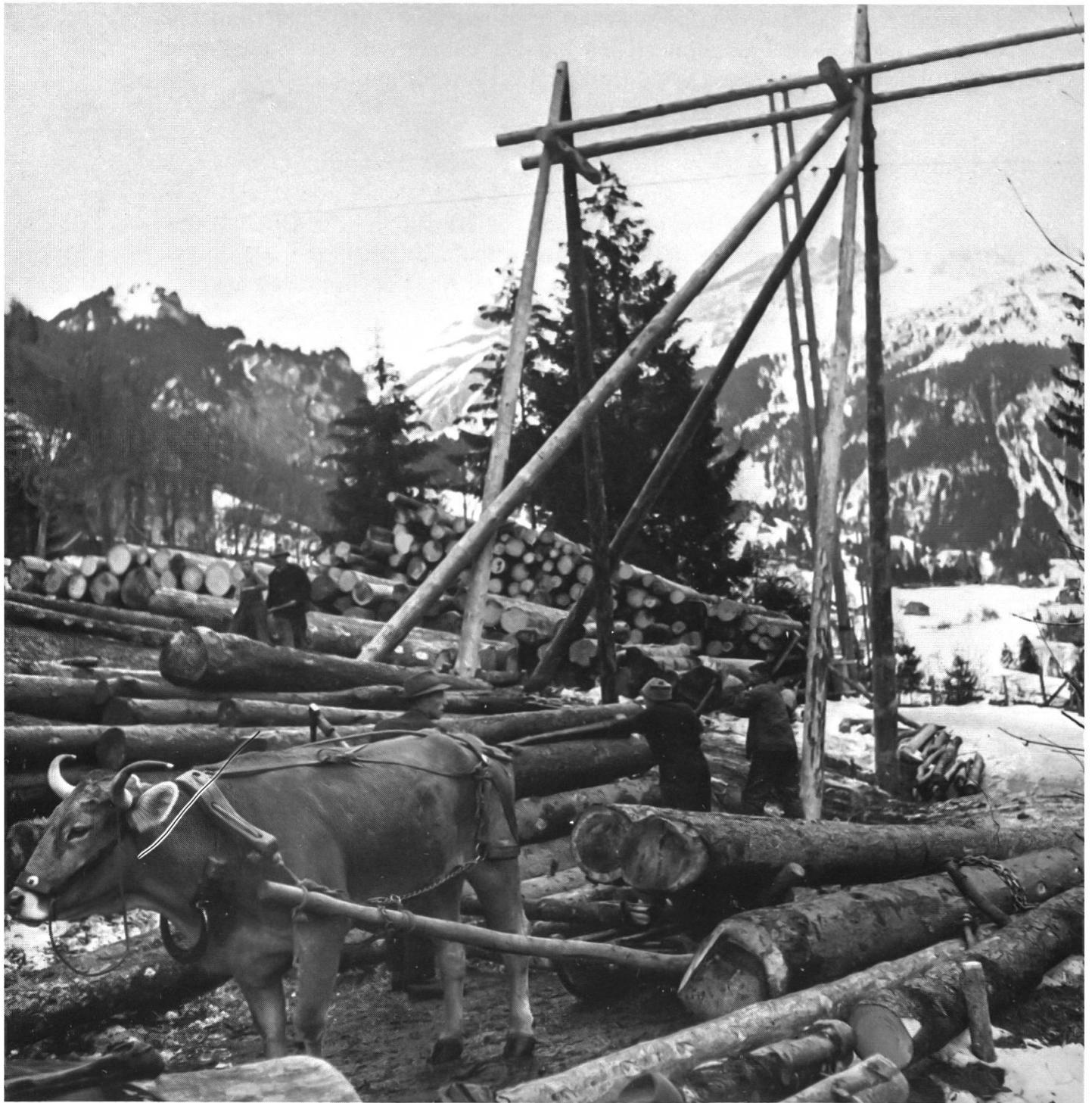
67 Holzwerk in Oberrickenbach ob der Kirche unter dem Ferienheim, Sammelplatz für das Lawinenholz von Sinsgäu. Die Stämme werden mit einem Zwick vom Drahtseil weggezogen. Aufnahme aus dem Jahr 1945.
