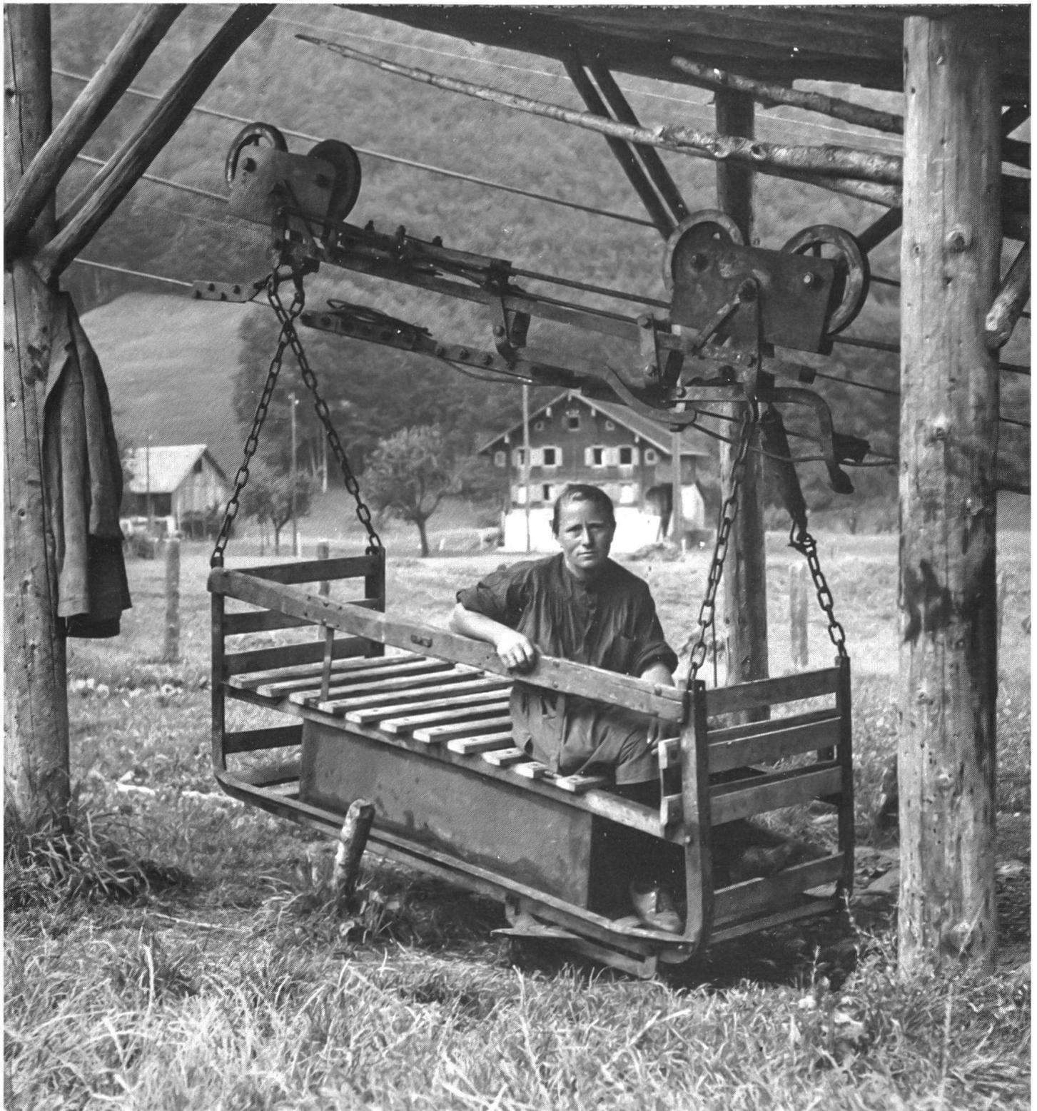
70 Seilbahnen überwinden auch das unwegsamste Gelände. 1909 wurde die Seilbahn Stegmatt-Vorder Diegisbalm als erste Anlage in Nidwalden erbaut. Heute besitzt Nidwalden eines der dichtesten Seilbahnnetze der Welt. 1981 verkehrten in Nidwalden 36 für Personentransport konzessionierte Seilbahnen und 85 Materialseilbahnen. Das Bild zeigt einen Karren der 1927 erbauten LSB Münchmatt-Büelen. Im Bähnchen sitzt Emma Aschwanden.
