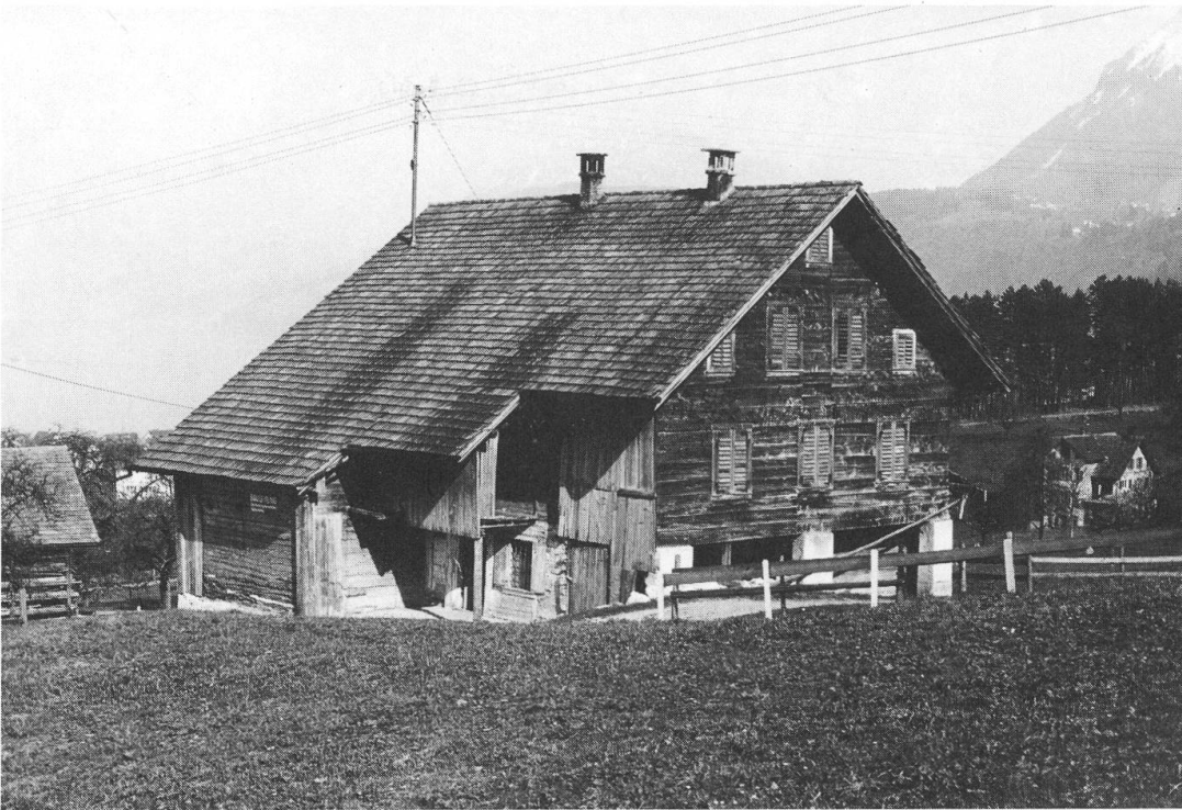
Abb. 1 Das Haus «Gross-Stämes» mit Blick auf die um 1914 unschön erweiterte Südfront und die Westseite samt Hauseingang. Links davon das Schild «Bauleitung». Foto: P. Adelhelm Bünter, April 1969
