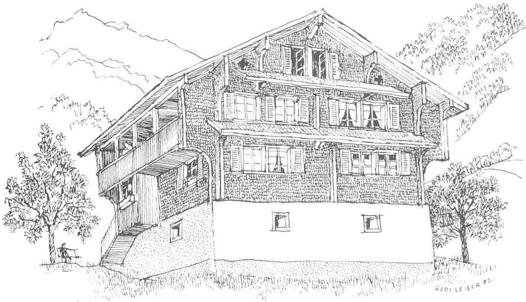
23 Wang, Wohnhaus um 1812, Niedriggiebel erinnert an das sogenannte Nidwaldner «Tätschihuis». Lukarnen aus der Bauzeit, die obere Ausladung ist nur links als offene Vorlaube behandelt, während sie auf der anderen Seite in den festen Wohnbau einbezogen ist.
