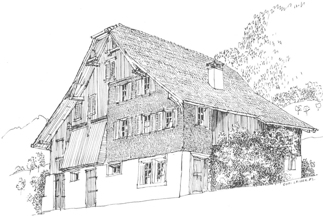
12 Langmattli, ein Gadenhaus: Die Bauform, in der Wohn- und Wirtschaftstrakt unter einem Dach miteinander verbunden sind, ist in Nidwalden selten anzutreffen. Während der Hausteil als Blockbau errichtet ist, musste der Gadenteil als Ständerbau konzipiert werden (Durchlüftung).
