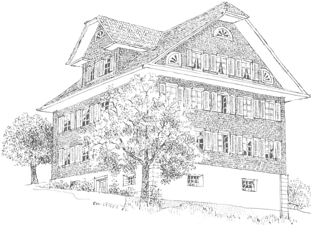
13 Schützenmatt: Stattliches Wohnhaus, um 1860 von Remigi Odermatt erbaut, mit Krüppelwalmdach und Dachgaube, Betonung der Ecken durch angedeutete Risalite. Für die Bauzeit typisch sind die Viertel- und Halbkreislukarnen.
