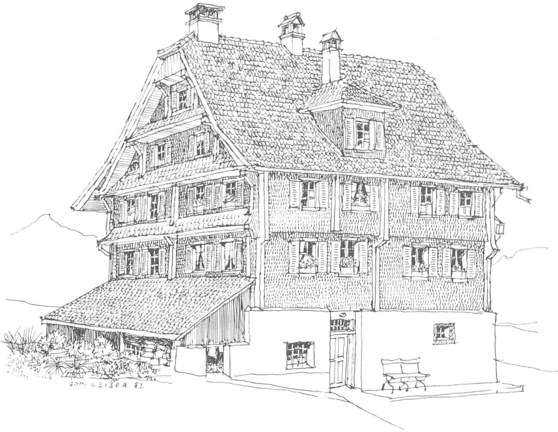
21 Christenmatt, Wohnhaus um 1814 errichtet, hochgieblig, Krüppelwalm und Klebedächer nach Art des Luzerner Bauernhauses, ebenso die traufseitige Vorkragung im Obergeschoss.
