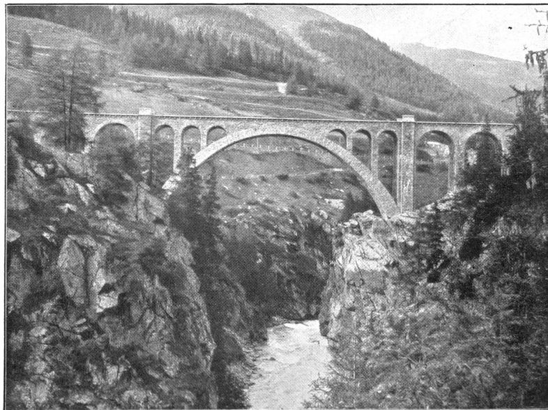
Großer Inn-Viadukt bei Cinuskel
