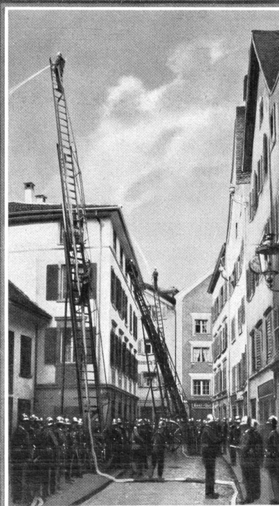
POMPIERCORPS BEI DER ARBEIT.
