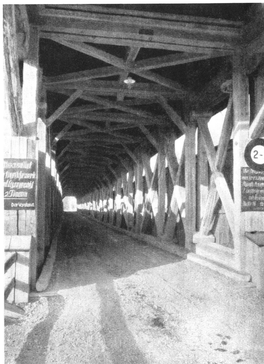
Blick durch das Innere der alten Brücke
