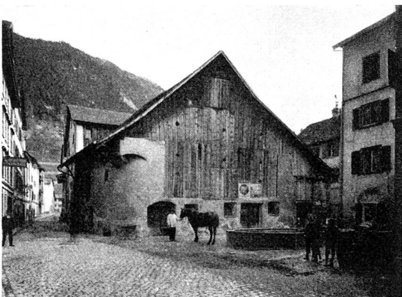
In der Storchengasse stand bis 1907 ein großer Stall. An dessen Stelle wurde damals durch Paul Lampert ein großes Geschäfts- und Wohnhaus gebaut, das viele Jahre später an den Konsumverein verkauft wurde und heute der Druckerei Bärtsch gehört. (Photo Salzborn).
