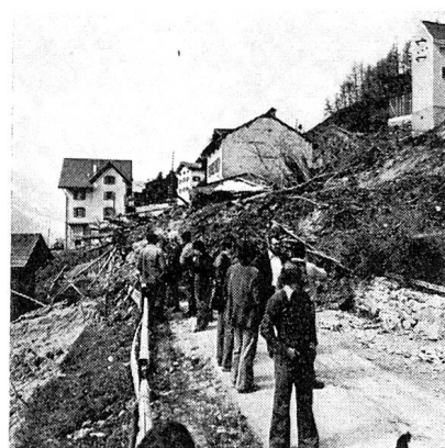
Schutt und Stalltrümmer bedecken die untere Dorfstraße.
