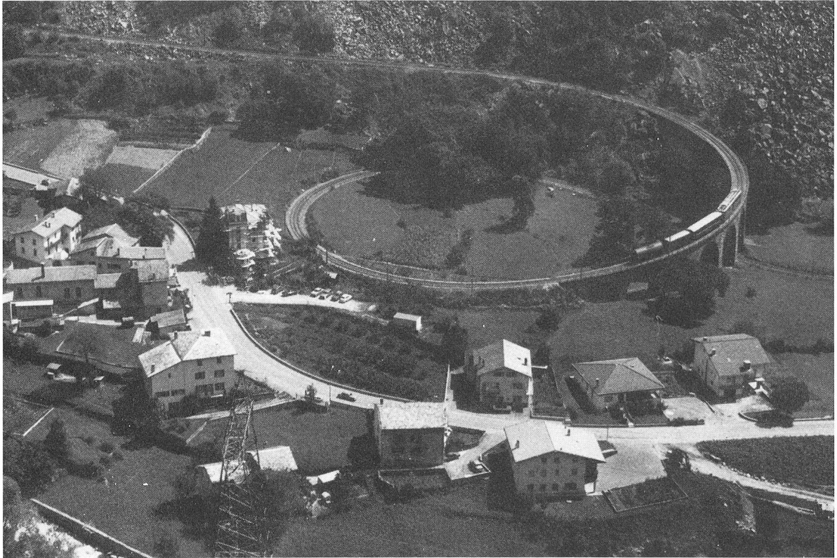
Im sonnigen Süden unterhalb Brusio befindet sich der einzigartige Kehrviadukt der Berninabahn. Dasselbe Prinzip wie in einem Kehrtunnel wurde hier in der freien Landschaft angewendet, um die nötige Höhendifferenz zu erhalten. Der aus Bruchsteinen (Granit) gemauerte Viadukt weist neun Öffnungen zu je 10 m Weite auf. Foto: P. Caminada, Thalwil
