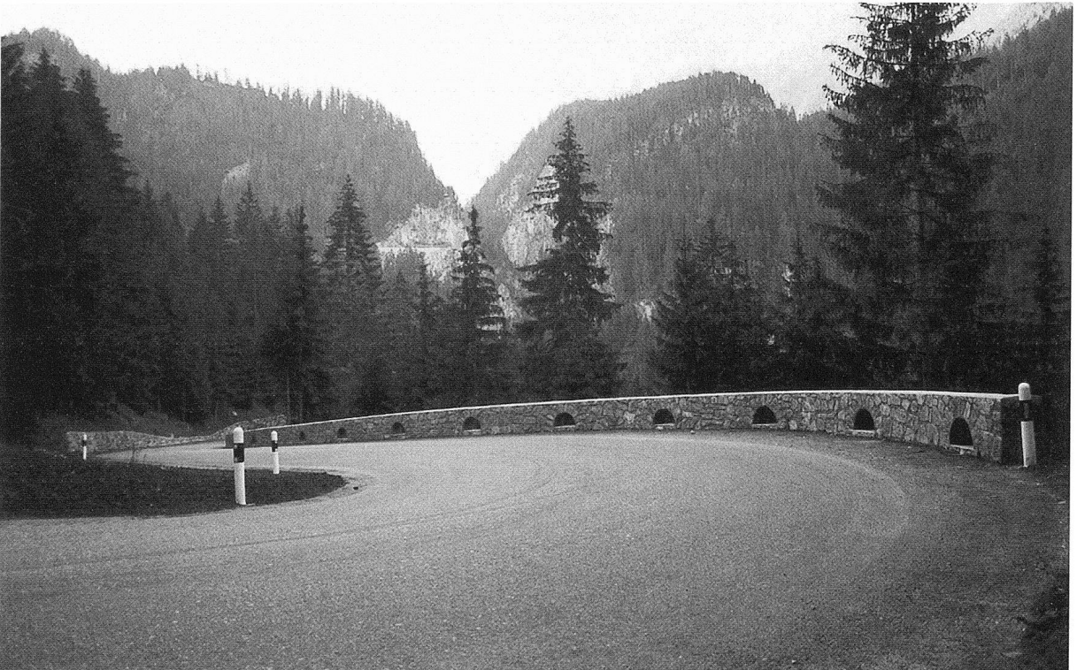
Fotos 3 und 4: Die Serpentine unterhalb des Crap vor der jüngsten Sanierung: Die von einem früheren Teilausbau stammenden Leitplanken wurden durch Brüstungsmauern ersetzt, um der Strasse möglichst ihren traditionellen Charakter wiederzugeben.
