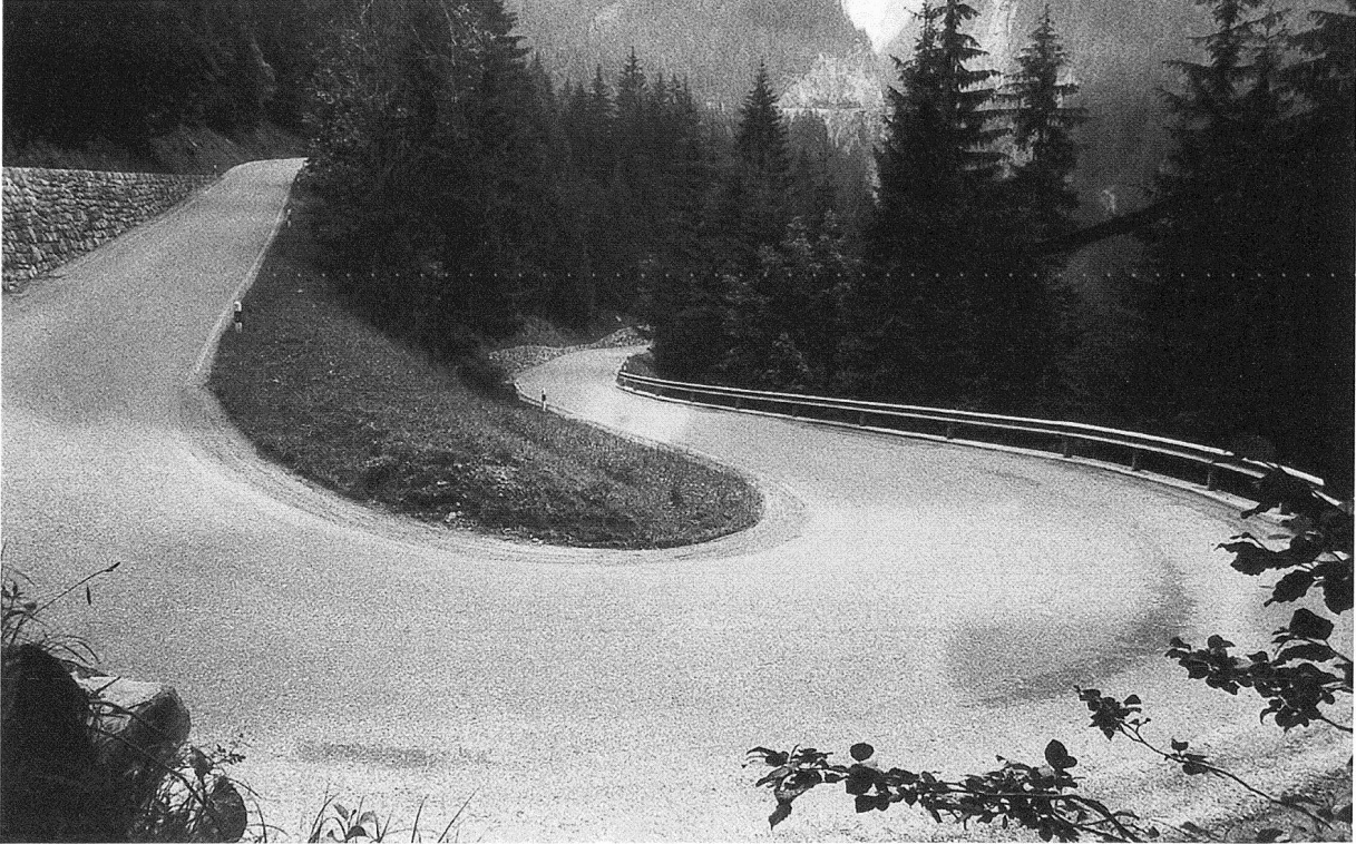
Fotos 3 und 4: Die Serpentine unterhalb des Crap vor der jüngsten Sanierung: Die von einem früheren Teilausbau stammenden Leitplanken wurden durch Brüstungsmauern ersetzt, um der Strasse möglichst ihren traditionellen Charakter wiederzugeben.
