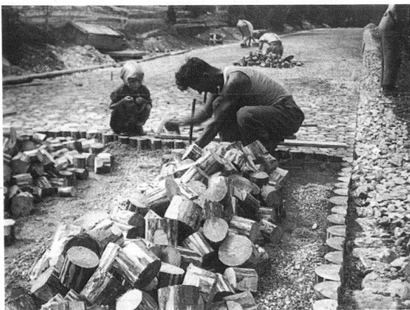
Abb. 5: Holzpflasterung bei Cazis im Jahr 1936.
