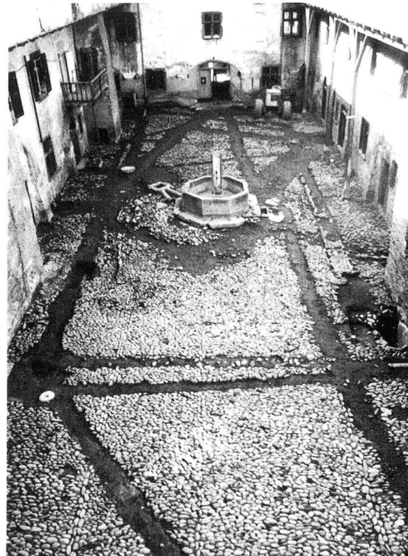
Abb.11: Die freigelegte Pflästerung im Innenhof, Übersicht von Norden.
