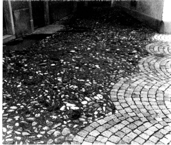
Abb. 20: Bivio. Übergang zur Gassenpflasterung in Bollenstein-Ausführung.
