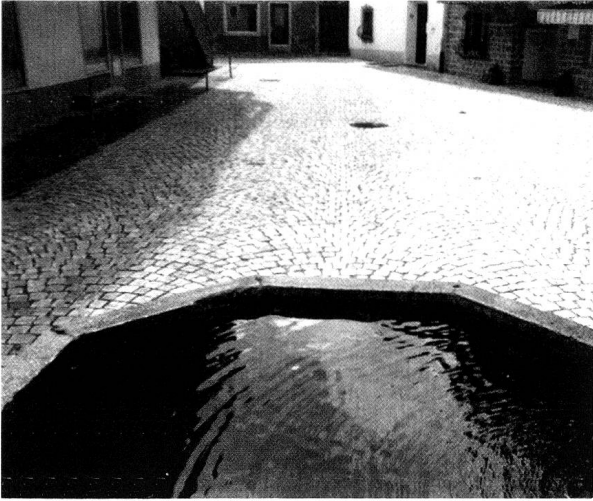
Abb. 19: Bivio. Brunnenplatz mit neuer Bogenpflasterung.
