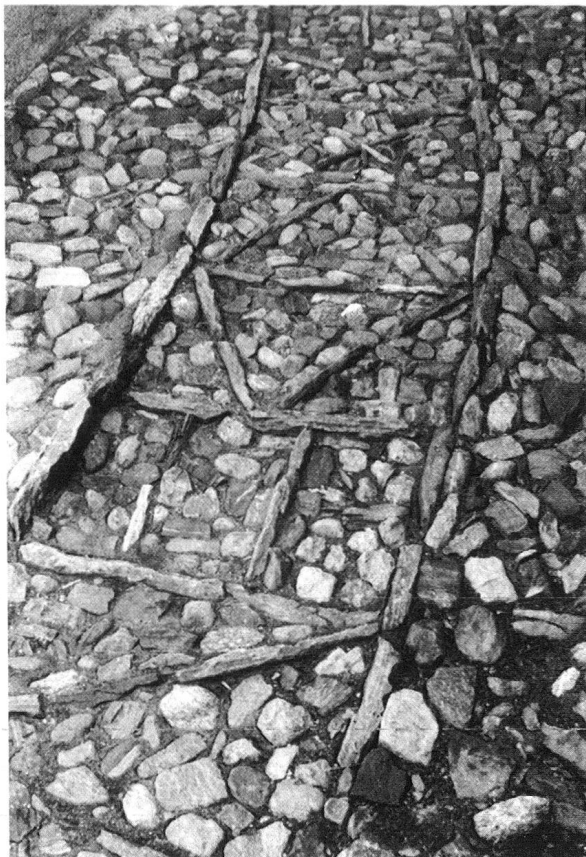
Abb. 22: Guarda. Rampe zur Hauseinfahrt eines Bauernhauses.
