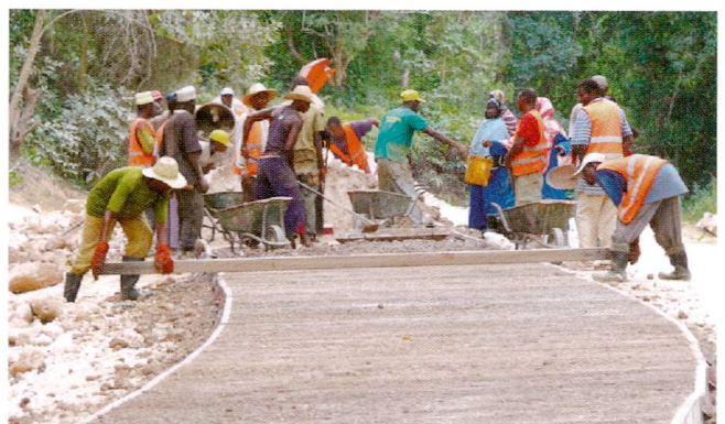
Arbeitsintensiver Strassenbau im Jahr 2011 in Pemba, Sansibar. (Foto AB)
