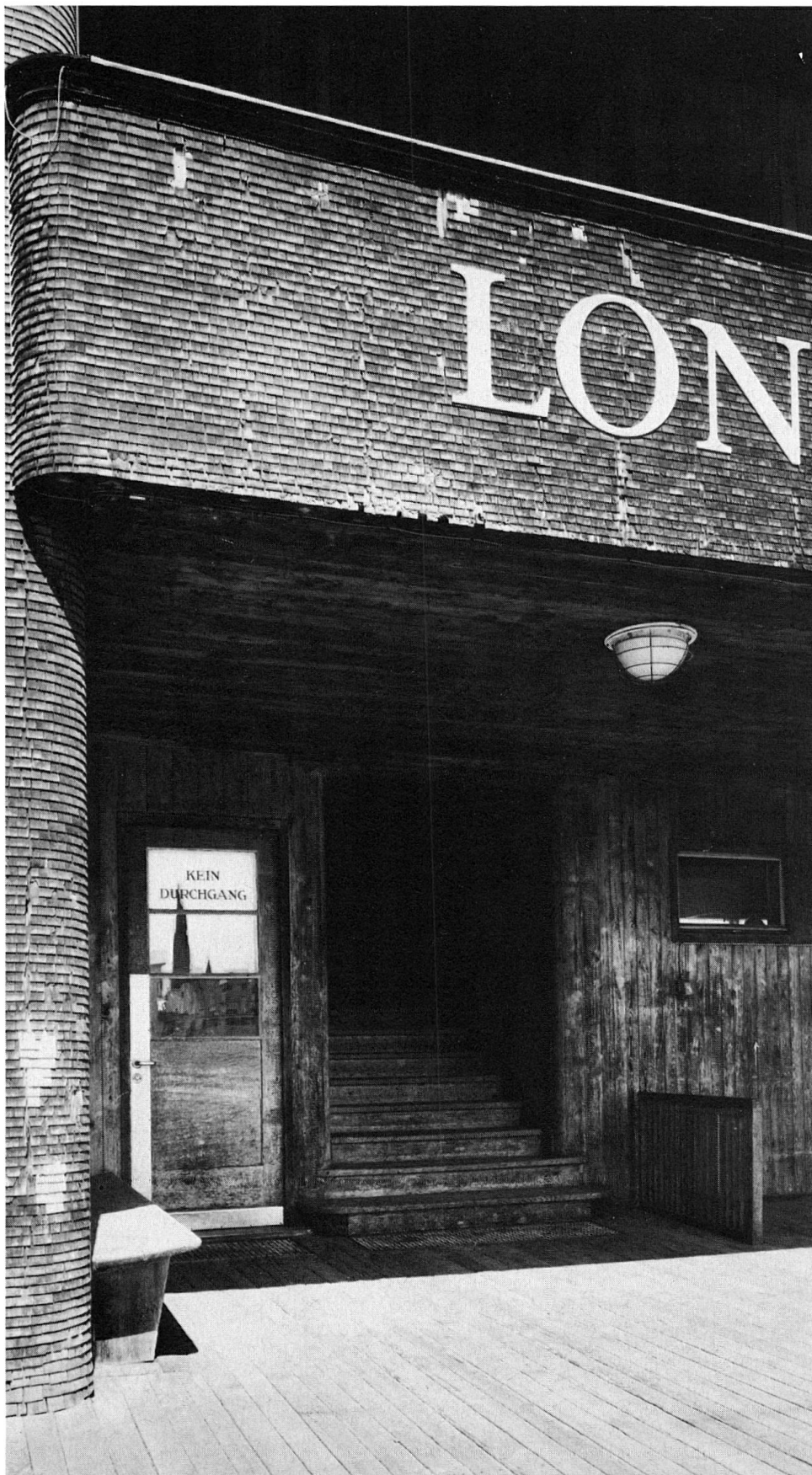
Anschluss- situation des Tri- bünentraktes an den Hochbau. Zustand 1988, Foto C.J. Gilli.
