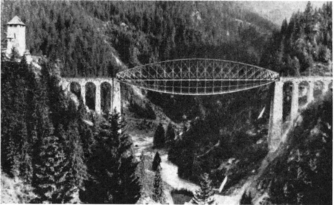
Trisannabrücke der Arlbergbahn.
