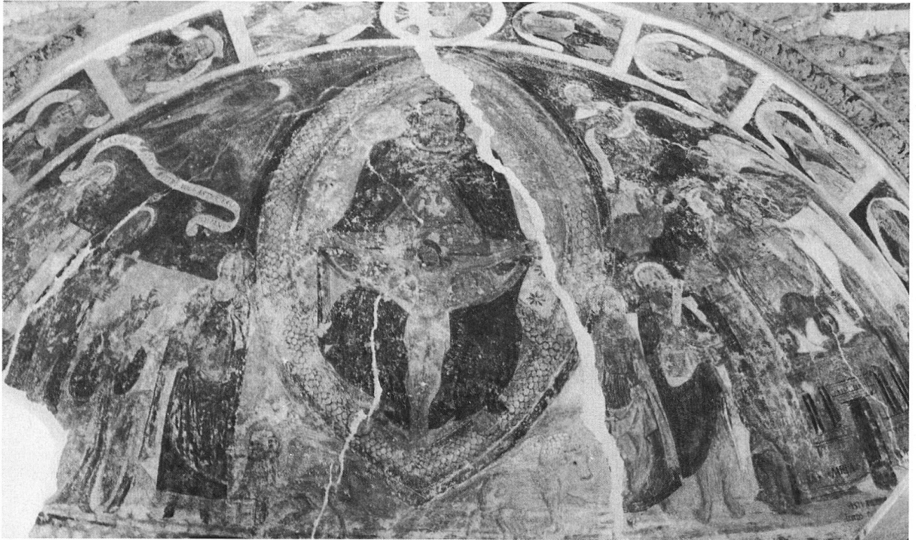
Abb. 8. Fex-Crasta, Kapelle, geöffneter Riss in der Apsiskalotte.
