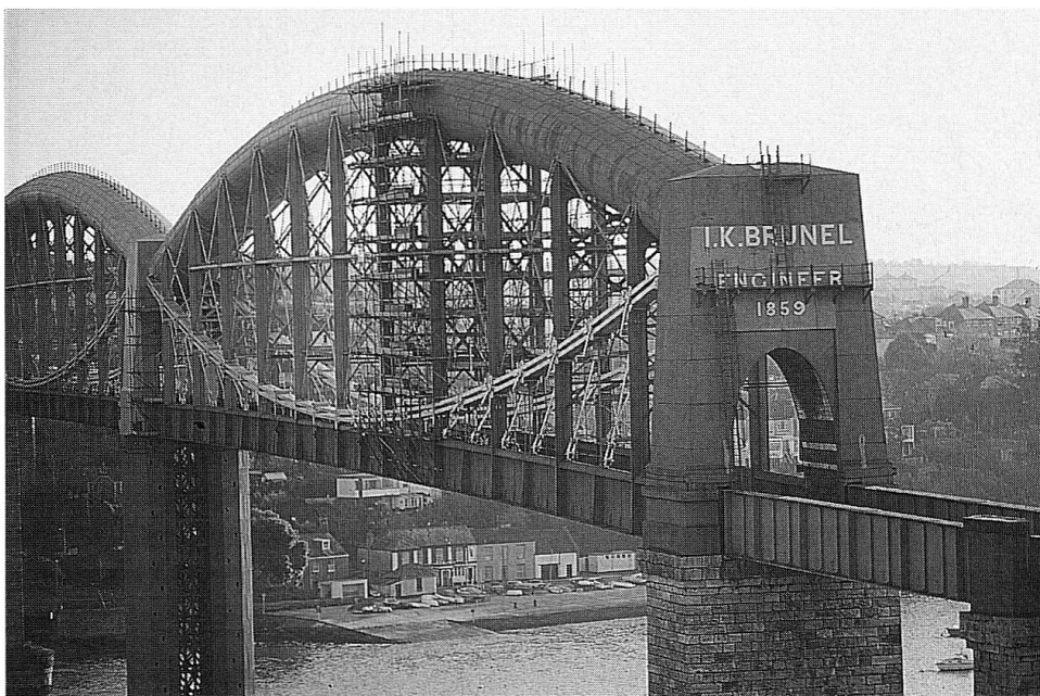
Isambard Kingdom Brunel (1806 – 1859): The Royal Albert Bridge über die Mündung des Tamar River bei Saltash (Plymouth), eröffnet 1859. Zwei Hauptöffnungen von je 136 m Spannweite. (Foto: Jürg Conzett)
