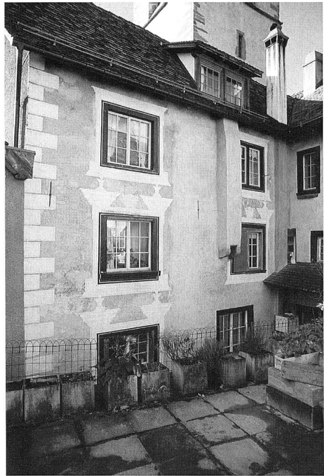
Haus Rainolter, rückwärtige Fassade. (Foto des Verfassers)
